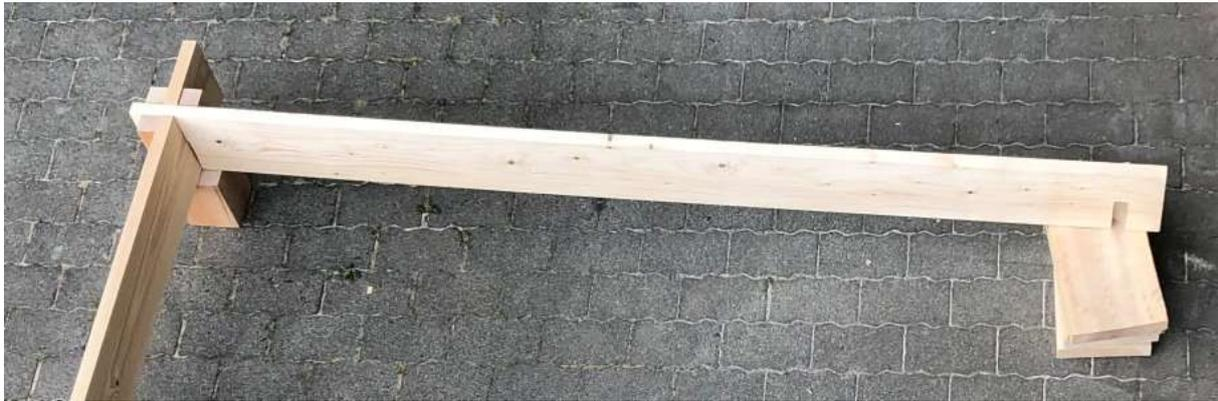
Abbildung 43: Einfache Steckbettvariante ohne Keile, Bild vom Bau, Foto privat
